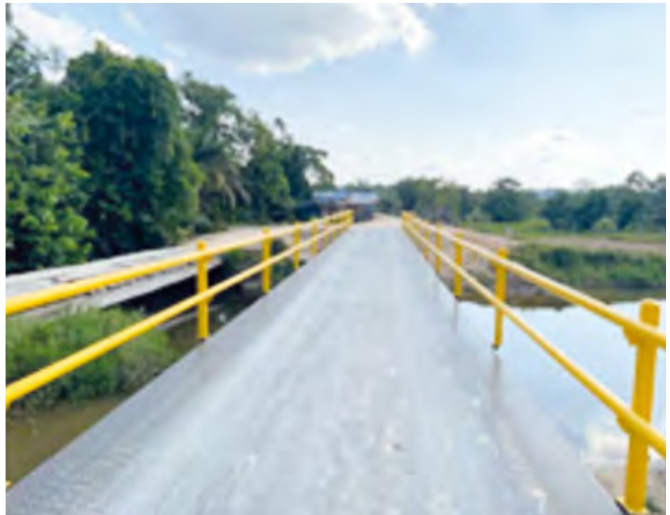
* Con recursos del municipio se construyó el puente metálico vehicular en la vereda Alto Parra, sector conocido como la 24.
