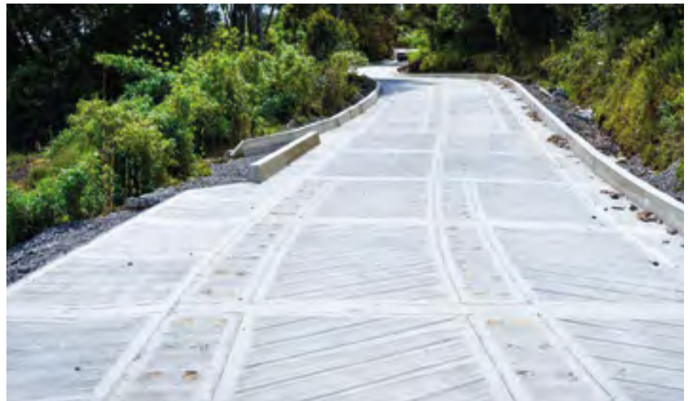
* 17 vías están siendo intervenidas para recuperación y mejoramiento de la movilidad.
