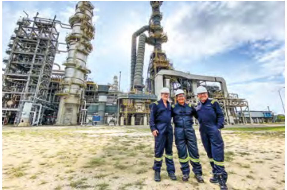
* Visita a la Refinería de Cartagena S.A. REFCAR. Planta de Hidrógeno Verde, macro proyecto de Ecopetrol.
